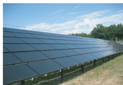
(c) 商品外観(昭和シェルソーラーの“ソラリス”, NEDO「大規模電力供給用太陽光発電系統安定化等実証研究」における北杜サイト設置例)
