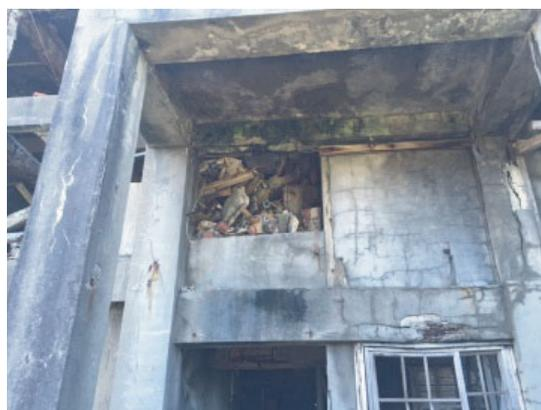
図4 軍艦島30号棟の劣化状況の一例 さびた鉄筋が露出し、建物表面のコンクリートが剥離している。また、上層階の床が下層階へ崩落し、がれきが堆積しているスパンが見られている。
