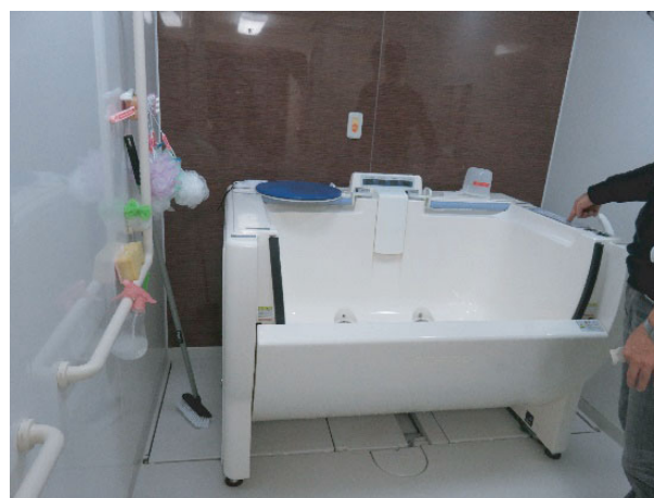
図4 壁面を開閉でき，またぐ必要のない介護用浴槽
