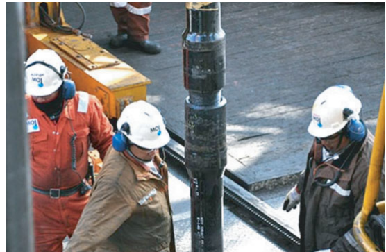
図10 海底掘削用ドリルパイプ 先端にドリルビット付きの10m長のパイプを継ぎ足していく。
