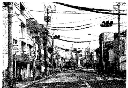
図1 東京都文京区における電柱と架空線 これに重ねて光ファイバ網を張りめぐらすことに、次代の日本の技術者の自尊心は耐えられるか。
